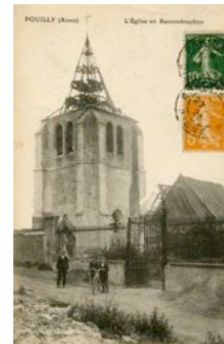
L'église en reconstruction Photo prise en 1920
