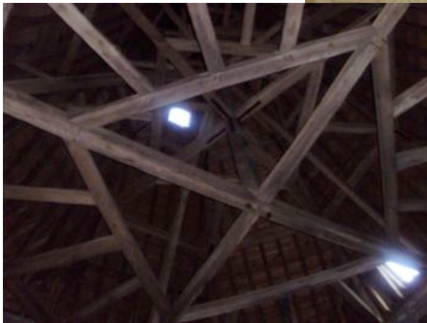
Charpente du XVII ème siècle
